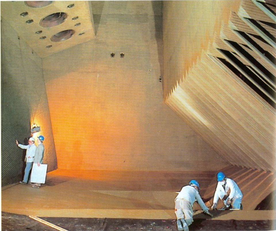
Stufenschmelzkammer eines 770 MW Dampferzeugers (um 1990).
