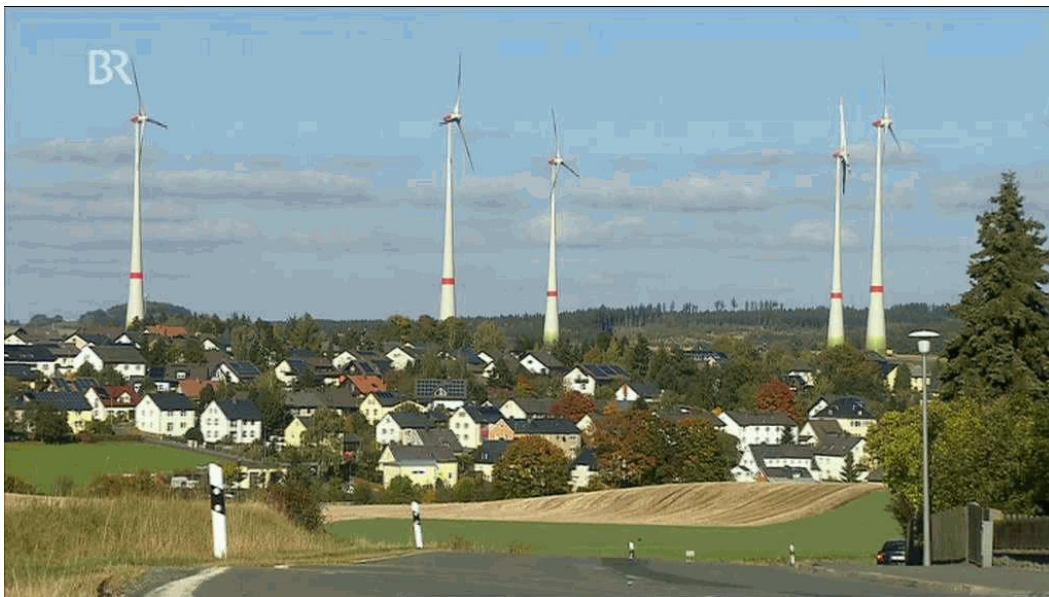
Abb. 18: In Regnitzlosau, Oberfranken, sind die Auswirkungen des Ausbaus der Windkraft im Binnenland in drastischer Weise zu sehen.
