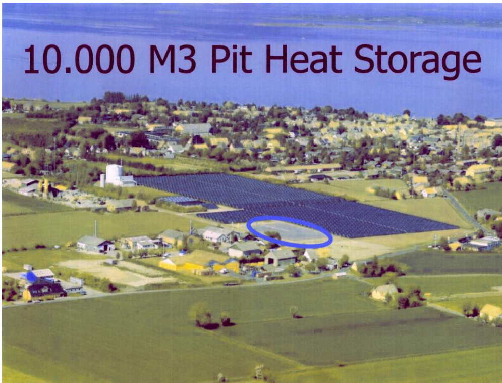
Abb.43: Große Solarwärme-Anlage in Marstal / Dänemark.
